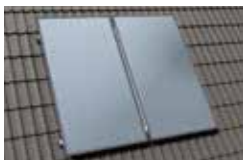
Sobre tejado inclinado
